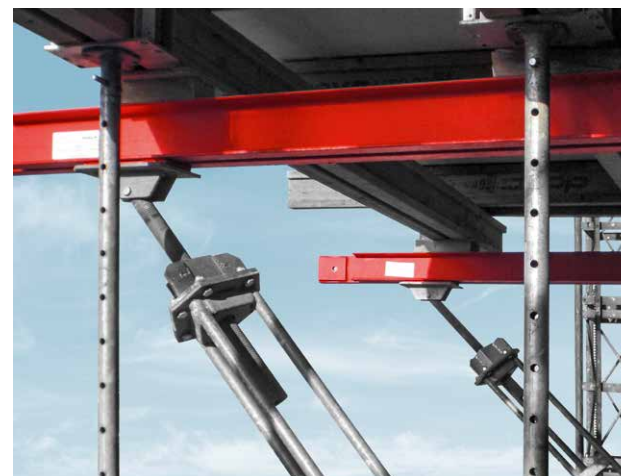
Tripex como apoyo para plataformas, en losas voladizas y balcones suspendidos.
